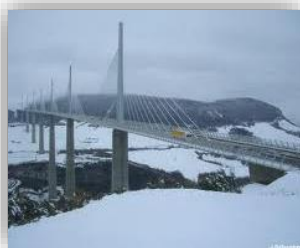
Viaduc de Millau
