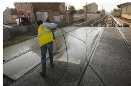
Le béton à désactiver sera mis en place par talochage, et si nécessaire, par vibration de courte durée. Une vibration trop forte du béton risque de faire ressortir la partie volumineuse des granulats en provoquant une séparation du mélange.
